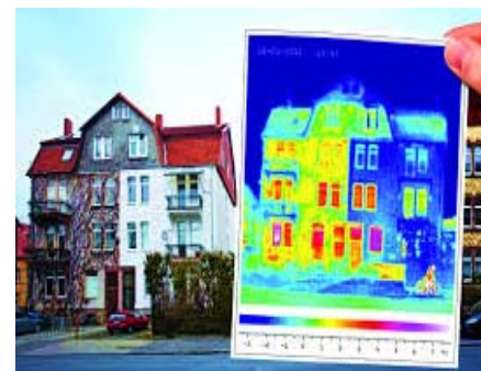
Beispiel Wärmebildaufnahme (Rechte Hausseite ist wärmegeämmt)
