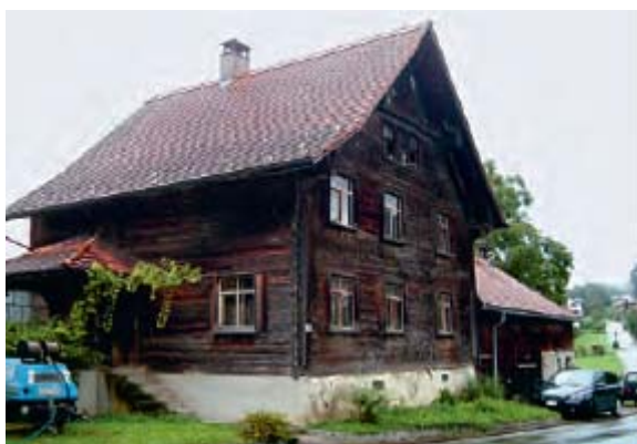
Gebäude vor der Sanierung
