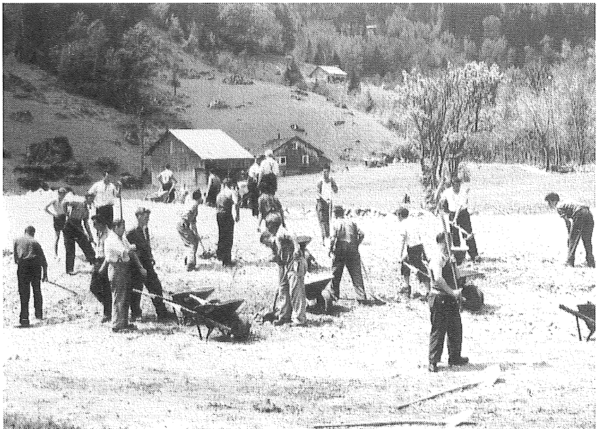
Aufräumungsarbeiten im Erstfeldertal bei Hermann Indergand.
